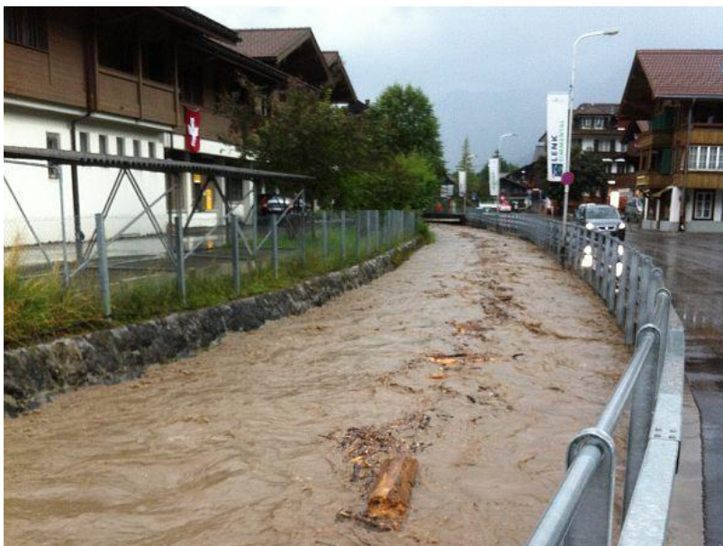
01.08.2014 : La Simme en crue à la Lenk BE, illustration de la situation toujours précaire en matière de crues en de nombreux endroits de Suisse (image : UIR / AEAI).
