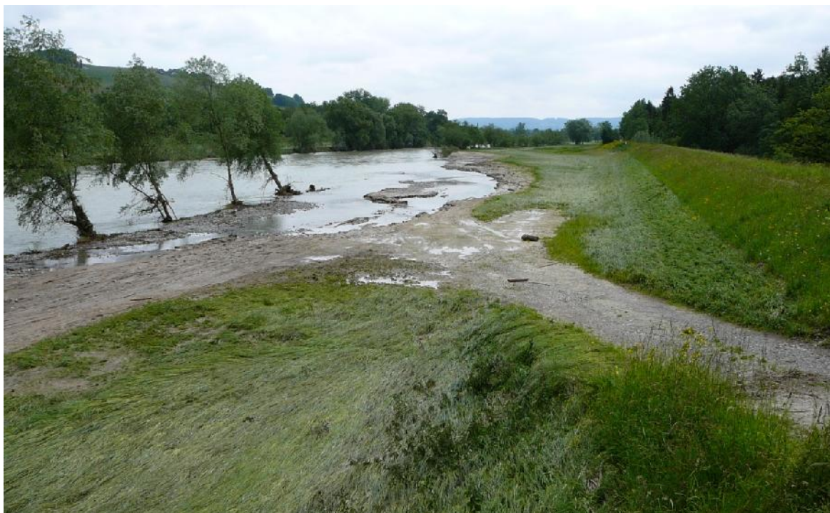
Spuren des 30-jährlichen Hochwassers im Thur-Kanal unterhalb von Uesslingen TG; die Bäume links im Bild markieren die Uferlinie vor dem Ereignis (Foto: IRV, 4.6.2013).
