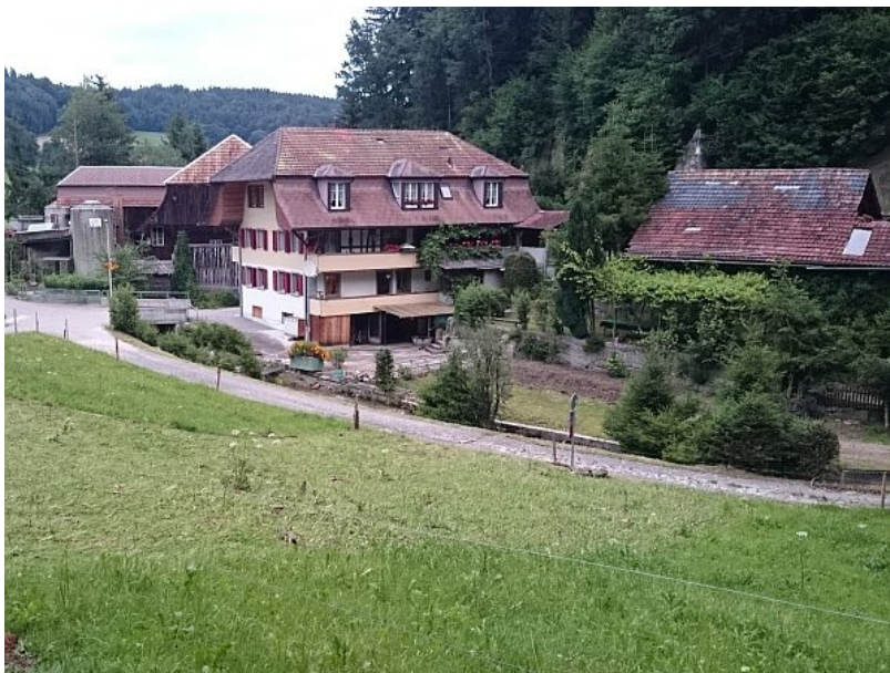
11.07.2014: Überschwemmungsspuren durch Oberflächenabfluss und Bachausbruch bei Niederscherli, Gemeinde Köniz BE (Bild: D. Bernet, GIUB).
