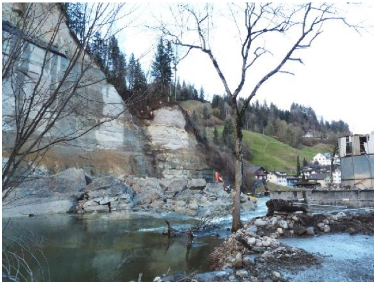
Links die Badflue mit den in die Kleine Emme gestürzten Felsmassen; rechts der Ausbruchbereich der Kleinen Emme; der Baum in der Bildmitte sowie das Gebäude rechts hinten weisen Schäden durch weggeschleuderte Gesteinsplitter auf. (Foto: IRV/VKF, 12.01.2016)
